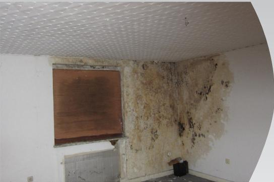
Bizarr: Ausgerechnet die immer dichter schließenden Fenster und höhere Wärmedämmung, mit denen wir der Umwelt und dem Energiehaushalt Gutes tun wollen, reduzieren den vorbeugenden Luftaustausch. Andererseits sind es u.a. gerade die Wärmebrücken – also Schwachstellen in der Hauswand, wo verstärkt Wärme austritt –, die den Schimmelpilz einlassen.
